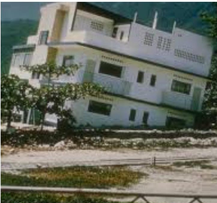
Esempi degli effetti della liquefazione in campagna o con edifici
