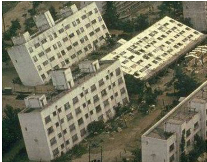
Esempi degli effetti della liquefazione in campagna o con edifici
